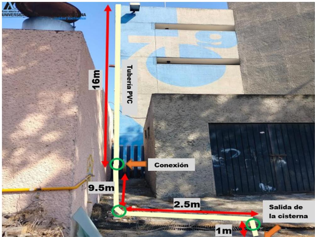
Figura 9 Transporte de agua hacia el área de uso
